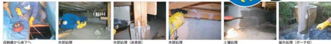
収納庫から床下へ 木部処理 木部処理(床下) 木部処理 土壌処理 屋外処理(ポーチ柱)
