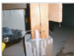
木部処理(床束部)
